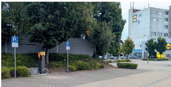
Ladesäule - Parkplatz Lidl
