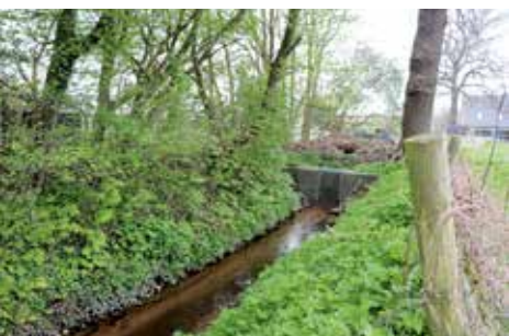
Der seit 2019 vorangetriebene und gutachterlich geprüfte Lösungsansatz für den Hochwasserschutz sah vor, auf Ellerbeker Seite am Übergang des Kellergrabens ins Rohrsystem (hier im Bild) die Rohre zu verlängern und zusätzlich einen kleinen Damm zu errichten. So sollte auf den angrenzenden Äckern Polderfläche entstehen, auf die das Wasser bei Bedarf kontrolliert abgeleitet werden kann.
