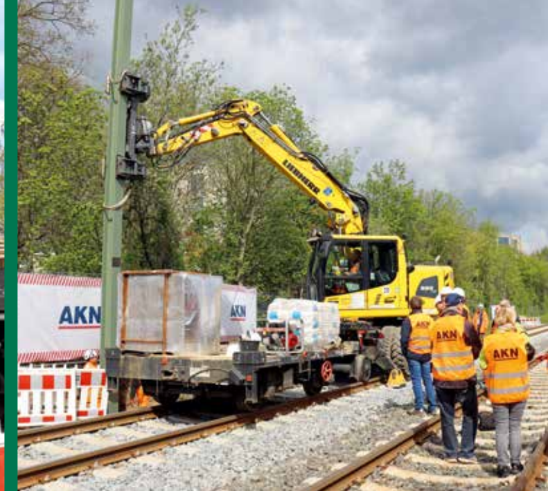
An der Station Hörgensweg in Hamburg-Eidelstedt wird mithilfe der Baumaschine der erste Oberleitungsmast in ein vorbereitetes Fundament eingebracht. Der Mast hat eine Höhe von 13,40 Meter.
