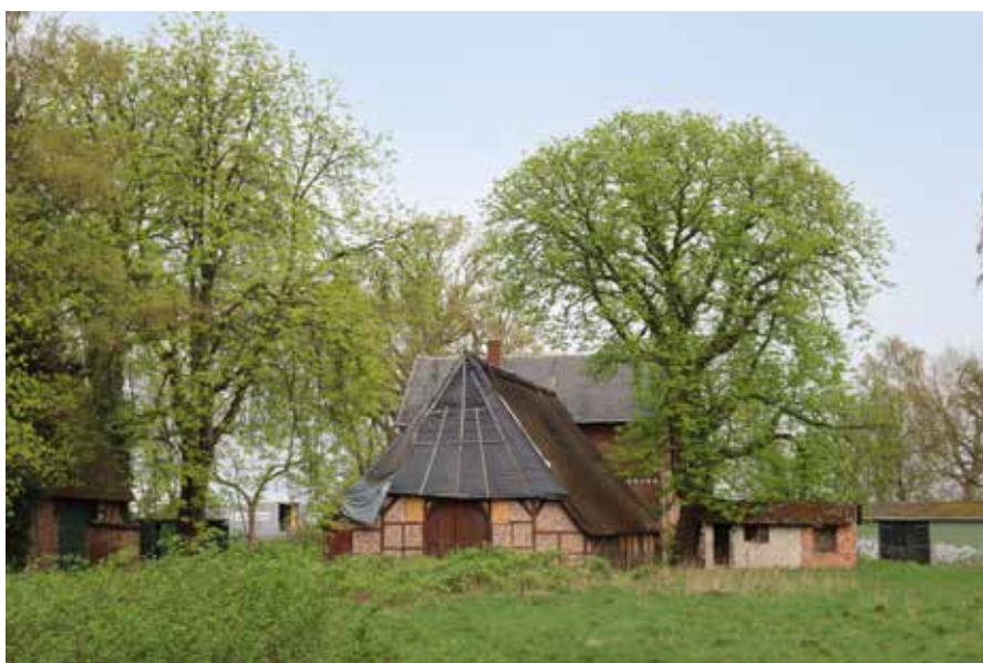
Der Sassenhof ist der älteste von drei noch existierenden Zeitzeugnissen der ursprünglichen Dorfstrukturen in Schnelsen. 1745 wurde er erstmals urkundlich erwähnt.
