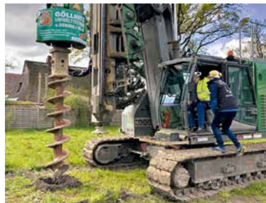
Erster Rammschlag – Baubeginn der neuen Polizeiwache
