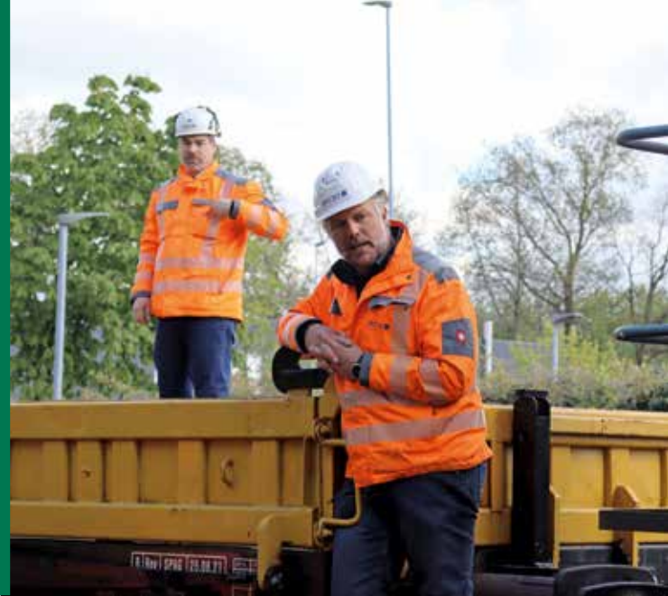
Björn Schmidt-Dudek, Leiter der Niederlassung des für die Oberleitungen verantwortlichen Unternehmens Spitzke SE, erklärte, wie das Fundament für die Oberleitungsmasten im Ramm- und Bohreindrehverfahren gegründet wird. Das Verfahren verursacht wenig Erschütterungen und Lärmemissionen
