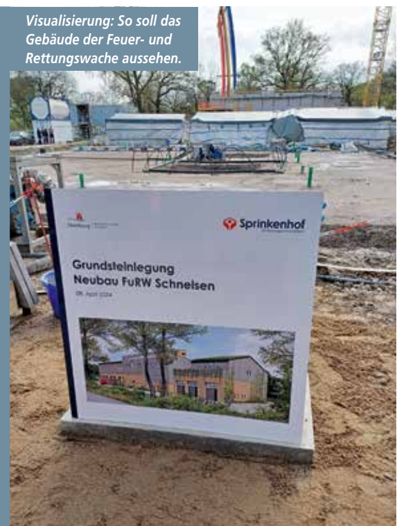
In zwei Jahren soll die 18. Hamburger Feuer- und Rettungswache am Schleswiger Damm in Betrieb genommen werden.
