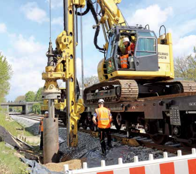
Mit der speziellen Baumaschine wird das Fundament für den Oberleitungsmast etwa einen Meter tief in die Erde getrieben.
