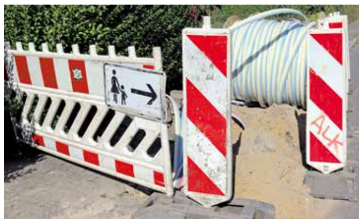
Der Glasfaserausbau wird in Ellerbek-Dorf fortgesetzt
