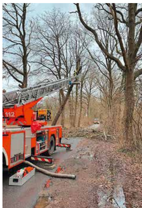
Mittels Kettensäge wurde der Baum abgetragen.
