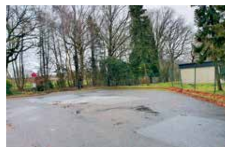
„Containerbrand“: Neuer Standort für die Papiercontainer im Gewerbegebiet Nordring.
